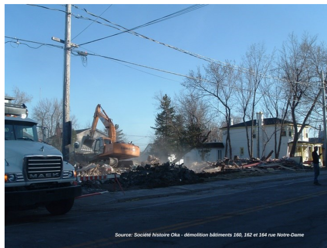
démolition 2005 no 160, 162 et 164
