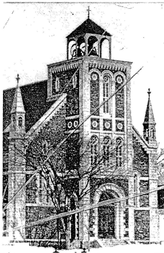
Fig. 4. Église actuelle et ses deux cloches. Louis Trépanier a monté les trois cloches le 24 juillet 1884 avec charpente-tourelle et couverture Photo : René Marinier, p.s.s.
