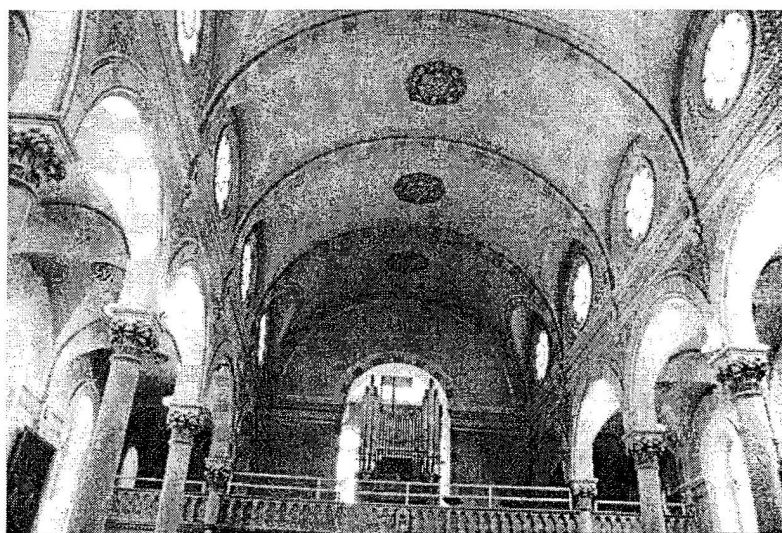
Fig. 6 La voûte en berceau et les arcs doubleaux, le jubé et l'orgue. À noter la peinture des arcs qui imite la pierre. Photo R. Beauchamp 10.08.99
