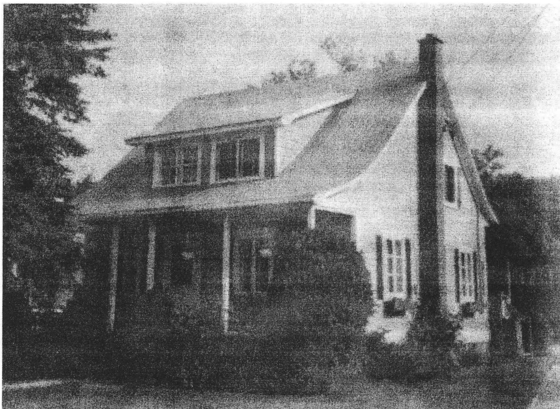
(Photo Pierre Bernard 1997) maison du 195, rue St-Joseph
