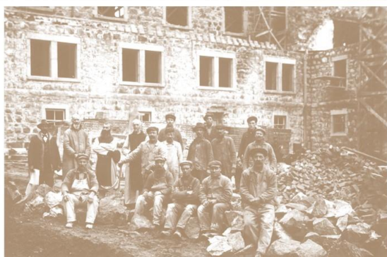
Planche 38: A) Réfection des clôtures le long du chemin L'Annonciation, travaux exécutés par une équipe dirigée par Raphaël Charest, été 1907. B) Travailleurs du chantier de reconstruction du presbytère, 1922-23. C) Équipe de maçons chargée de la reconstruction du monastère en 1917-18. Des moines suivent de très près les travaux. (Archives photographiques, Société d'histoire d'Oka)
