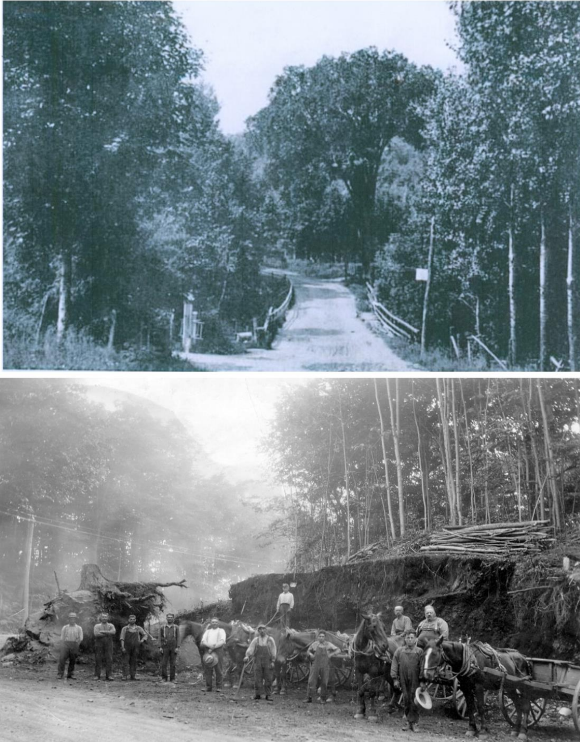
Figure 21 (21a) Le pont du ruisseau Rousse et la côte de l'Abbaye avant leur réfection, années 1910 (Archives SHO). (21b) Cantonniers occupés à la reconstruction du pont et à l'élargissement de la côte devant l'Abbaye, 1928 (Archives SHO).
