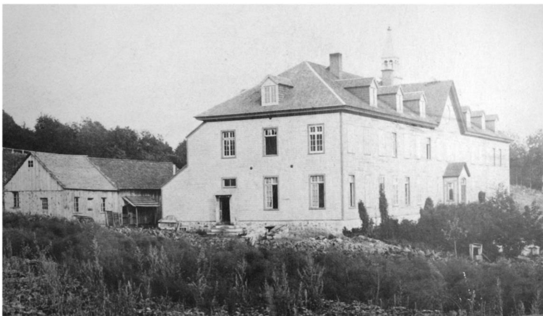
Figure 43 (43a) Moines réunis au réfectoire du premier monastère (1881-1891). (43b) Situé sur la colline St-Sulpice, le bâtiment devient rapidement trop petit et force la construction du deuxième monastère. L'édifice sert d'école d'agriculture à partir de 1893. Déplacé puis démoli, il sera remplacé par les bâtiments de l'Institut agricole d'Oka en 1928. (Archives, Abbaye Val-Notre-Dame)
