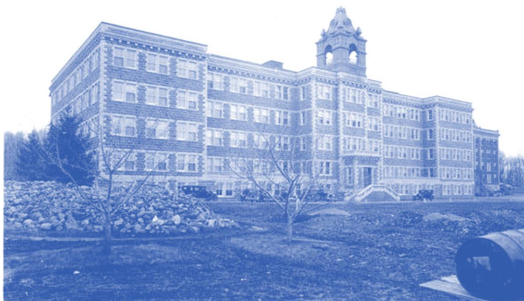
Figure 51 (51a) Session de travaux pratiques : un moine supervise un groupe d'étudiants chargé de planter des pommiers, années 1940. (51b) Nouveau bâtiment de l'Institut agricole d'Oka vers 1930. Situé à l'extrême droite, le pensionnat continue de servir tandis que les anciens édifices sont rasés pour faire place à la nouvelle construction. (Archives, Abbaye Val-Notre-Dame)
