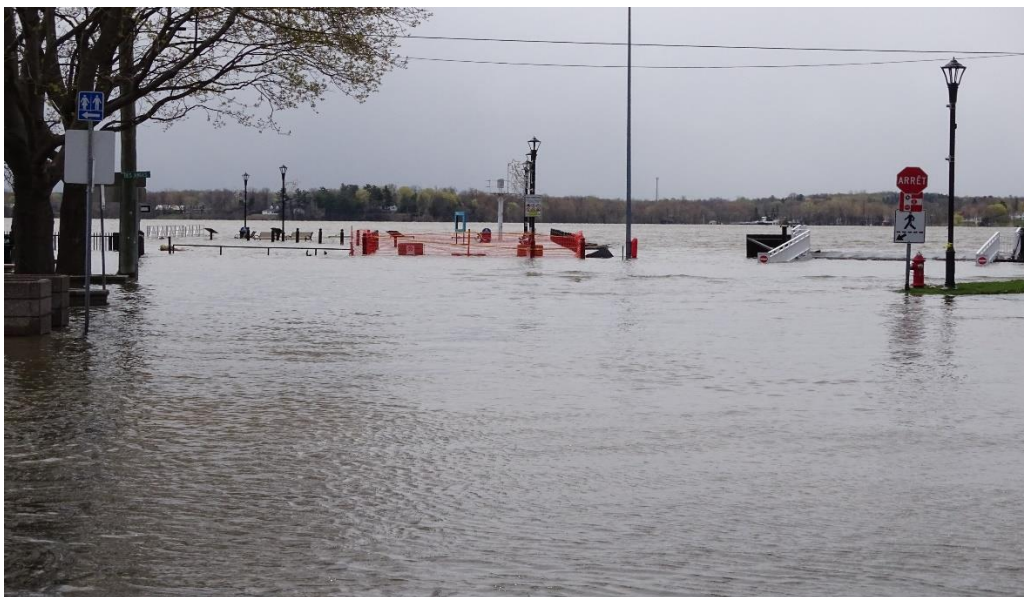
Mai 2017, le quai municipal d'Oka et les installations de la traverse Oka-Hudson submergés (photo Réal Raymond)
