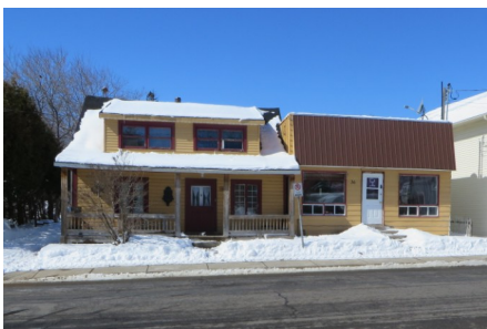
Premier bureau de poste, 36 rue de L'Annonciation
