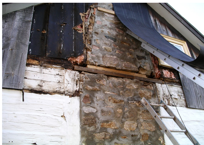
Fonds: Robert Turenne Maison Bérubé Une rénovation sur une maison bi-centenaire
