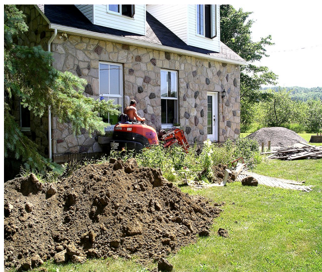
Fonds: Robert Turenne École St-Hippolyte Si la rénovation est souterraine, peut-on parler de préservation?...
