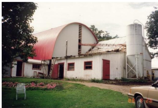
La nouvelle grange-étable. L'ancienne section, au premier plan, sera démolie en 1988
